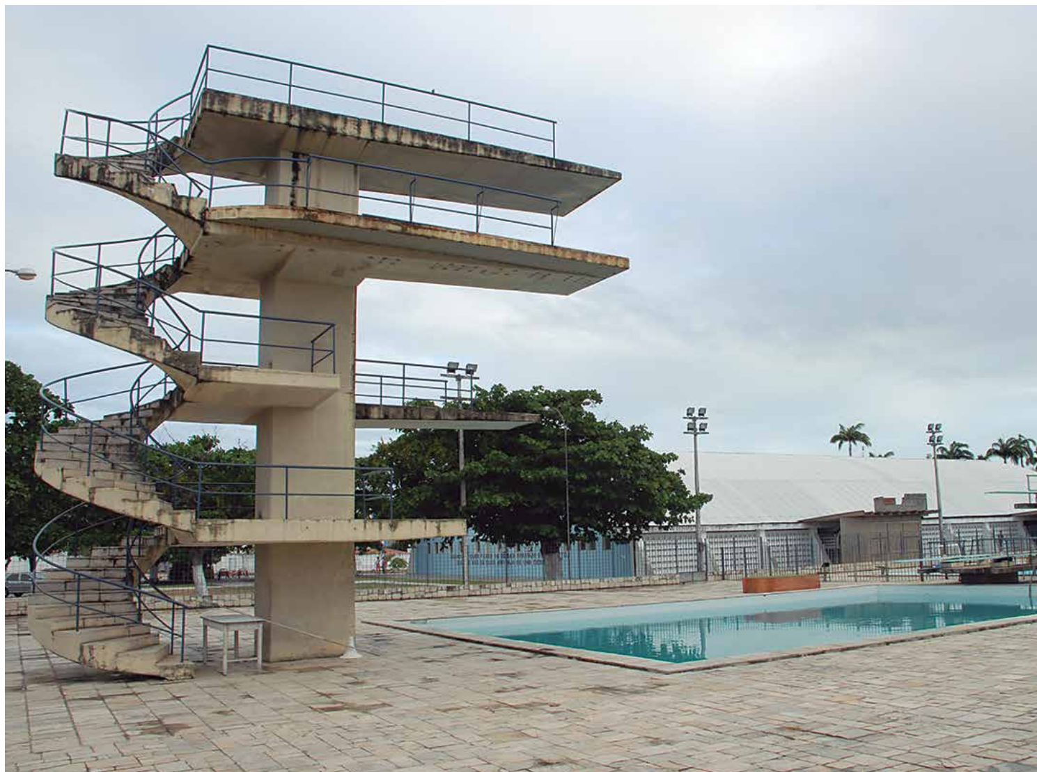
O Parque Aquático da Vila Olímpica também terá melhorias em sua estrutura com a execução das obras pelo Governo do Estado
